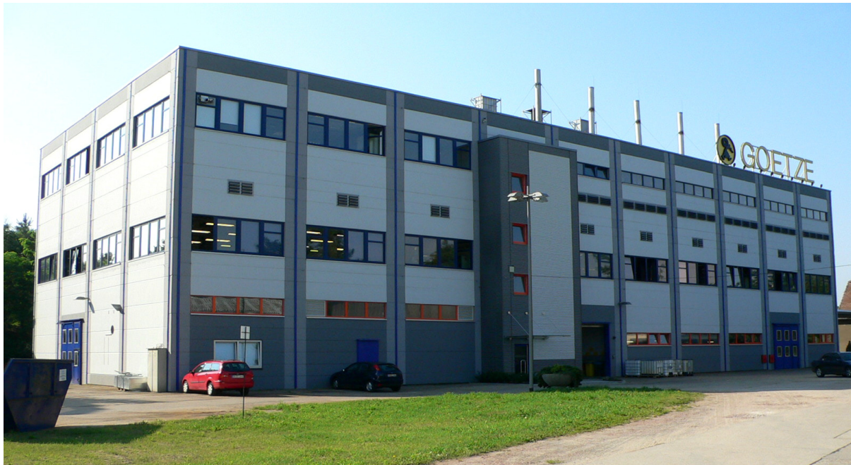
Foto: Federal-Mogul Dresden, Betriebsbereich Galvanik
